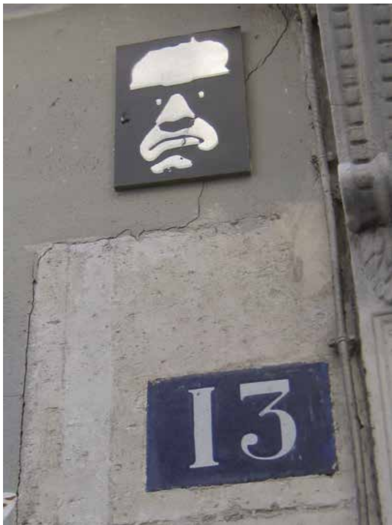
Fissure 13 – Collectif CrrC
